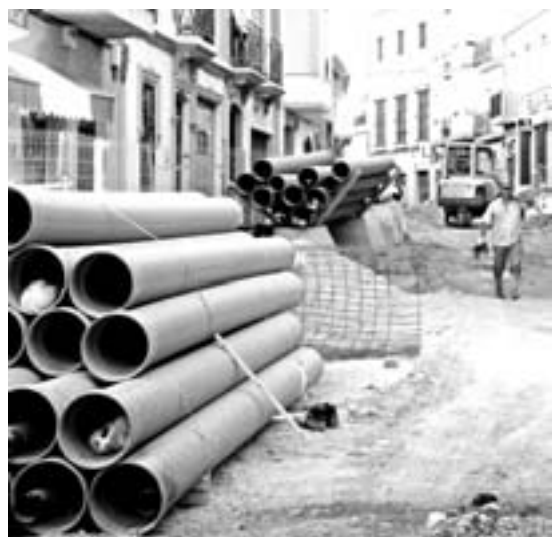
Obras que se desarrollan en la calle Carrera.
