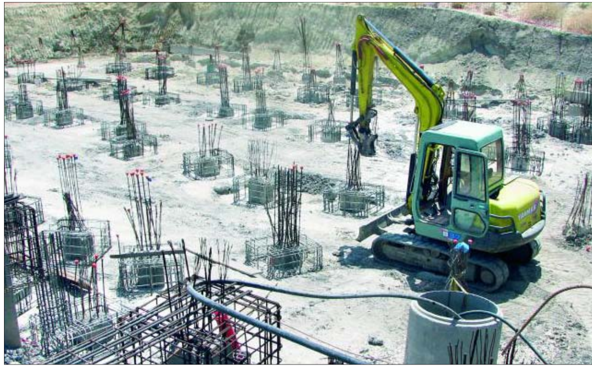
Trabajos para la construcción del hotel-balneario de la villa de Frailes.
