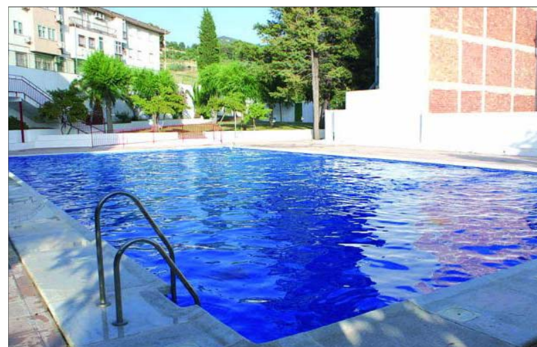
Instalaciones de la piscina municipal de Jamilena.
