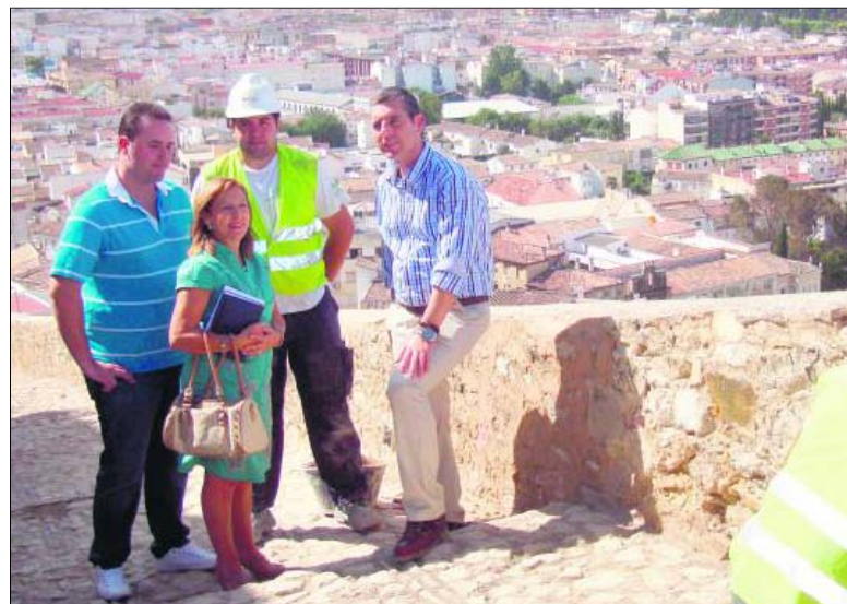
Jesús Gómez y Custodia Matos, en las obras de la muralla.
