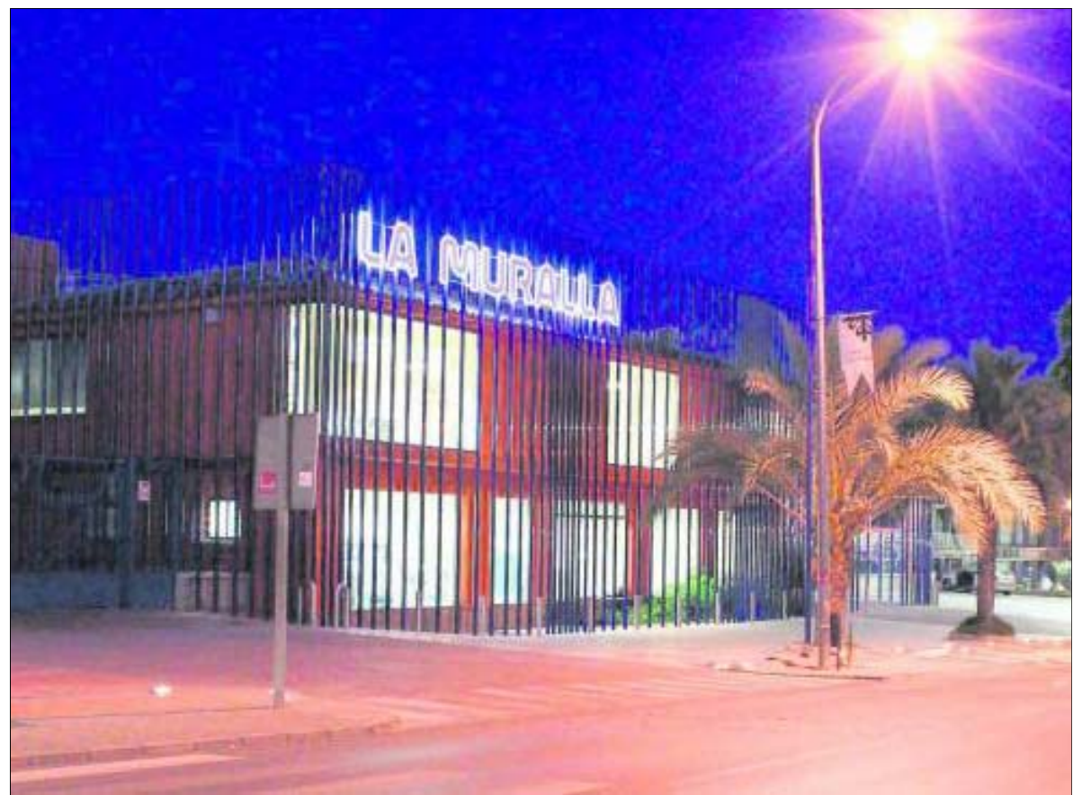
Instalaciones de Suministros La Muralla, S. L. en Alcaudete.
