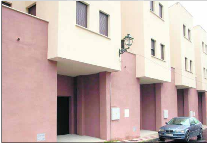
Casas de promoción oficial construídas por la Administración en una anterior promoción.
