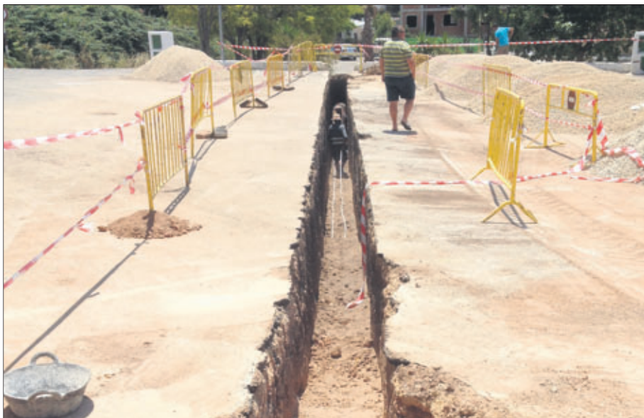
Obras de la conducción entre el sondeo y los depósitos municipales.
