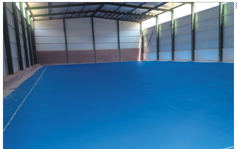
Aspecto del interior de la pista polideportiva cubierta
